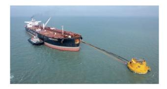
孟加拉单点系泊及双线管道项目是2016年习近平主席访问孟加拉时中孟两国达成的重要经贸合作成果之一,是孟首个海陆一体超大型石油储运工程。本行为项目提供融资支持。该项目包括建设单点系泊系统、罐区和站场等设施,以及铺设海上及陆上输油管道,实现了中国资金、中国技术、中国设备、中国施工的"全产业链"建设。项目建成后可大幅提高运输效率,并减少原油泄漏造成的环境污染,对保障孟能源供应需求、推动地区经济发展有重要作用。2024年8月8日,项目签发接收证书,完成移交工作。
